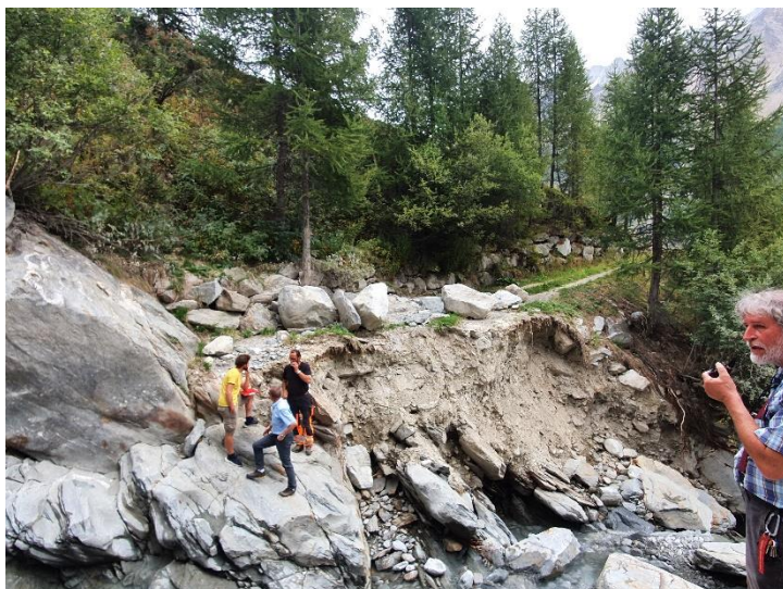
Aufnahme Begehung vom 30.08.2022 – komplexe Situation – viele Experten und viele Meinungen
